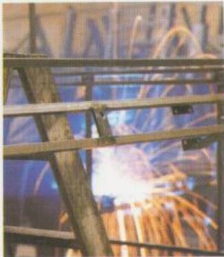
Geschweißter Stahlprofilrahmen des Hytermobils.
