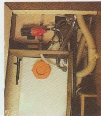
wintertaugliche Verlegung der Wasserver- und -entsorgung.
