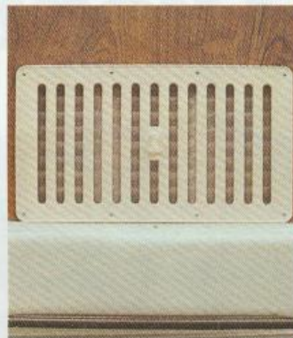
Zwangsentlüftung in der Eingangstüre.
